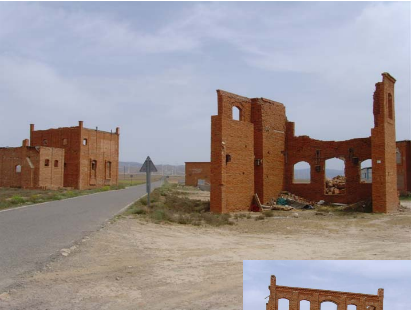
Nur die Backsteinmauern sind von „Flagstone“ übriggeblieben. Blick nach Norden auf die Sierra de Baza
